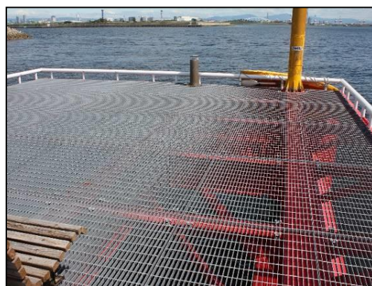
海上構造物のグレーチング
