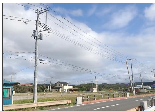
塩害地の配電柱および部材
